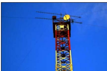
Sl. 62.a. Antenski stub YU7AR i antene za 432MHz
