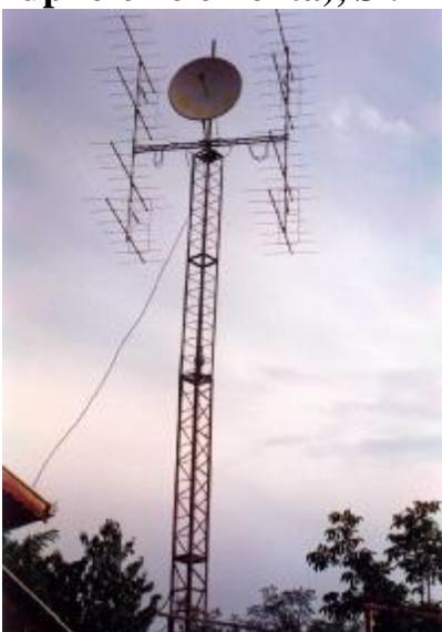
Sl. 72 Antenski sistem za 144 MHz stanice YU1EV od 4 X 8el. SLOT po dizajnu „K8AT“ (KN04CN), početak 80-tih godina XX veka
