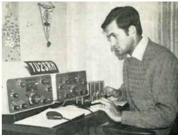
Sl.39c Savremeni SSB uređaji za KT u Savezu radio-amatera Hrvatske; operator na stanici YU2SRH (RX SB300 i TX400 a antena je bila W3DZZ, koju je proizvodio SRH)
