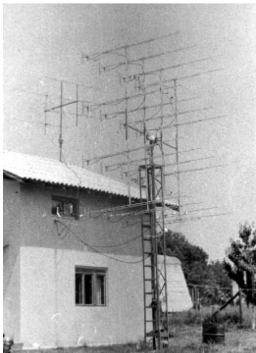
Sl.74 Novi antenski sistem za 432 MHz stanice YU1EV, od 16 X 23el. Frakaro (KN04CN); Moma je u ovom ant.sistemu bio ugradio i antensko prepojačalo sa čuvenim MGF1400A
