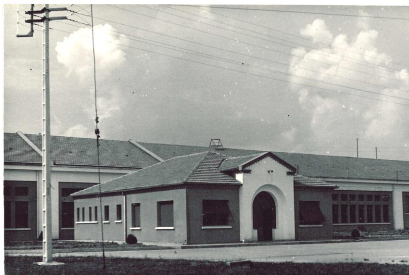
Centre Emetteur du Vernet. Bâtiment d'émission E2
