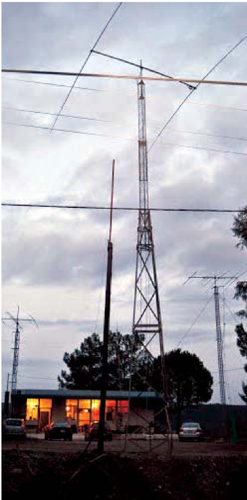
Σταθμός και κεραιές σε μια εντοπωσιακή φωτογραφία.
