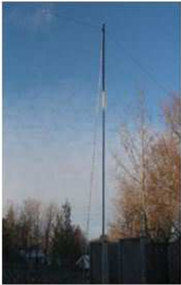
Belle installation d'une G7FEK chez VE3SCP. Section verticale de 7,40 m; sections horizontales de 11,58 m et 2,43 m.
