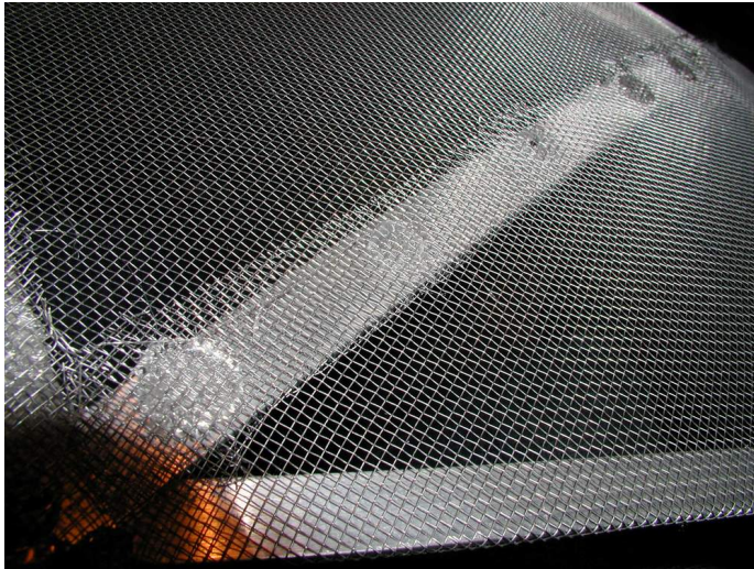
Figure 5 : Détail d'un raccordement de grillage entre deux secteurs
