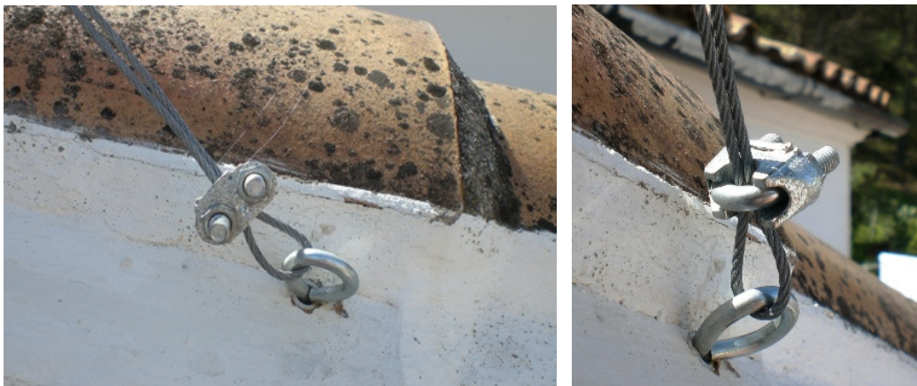
Sujeta cables ó "perrillos"
