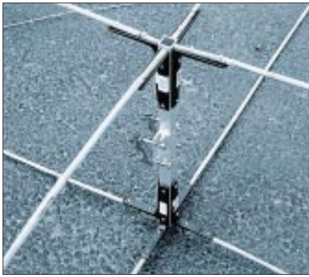
Bild 5: Befestigung der Spreizer mit Regalträgern
