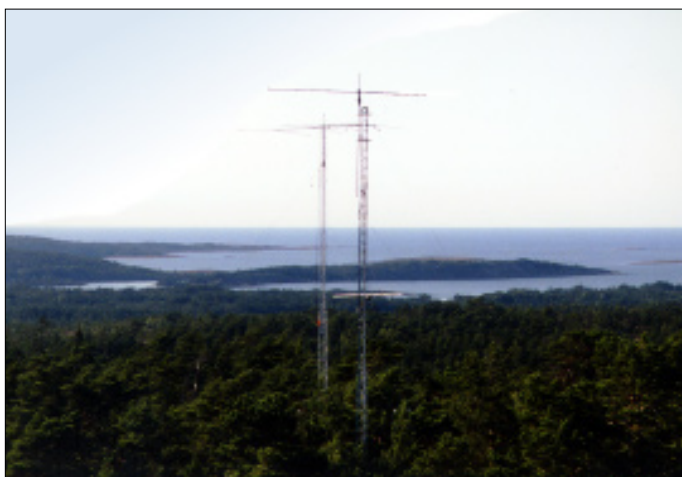
Das Take-off in Richtung USA; vorn die 2 x 5-Ele.-10-m-Beams, dahinter der TH7DXX in 22 m Höhe.
