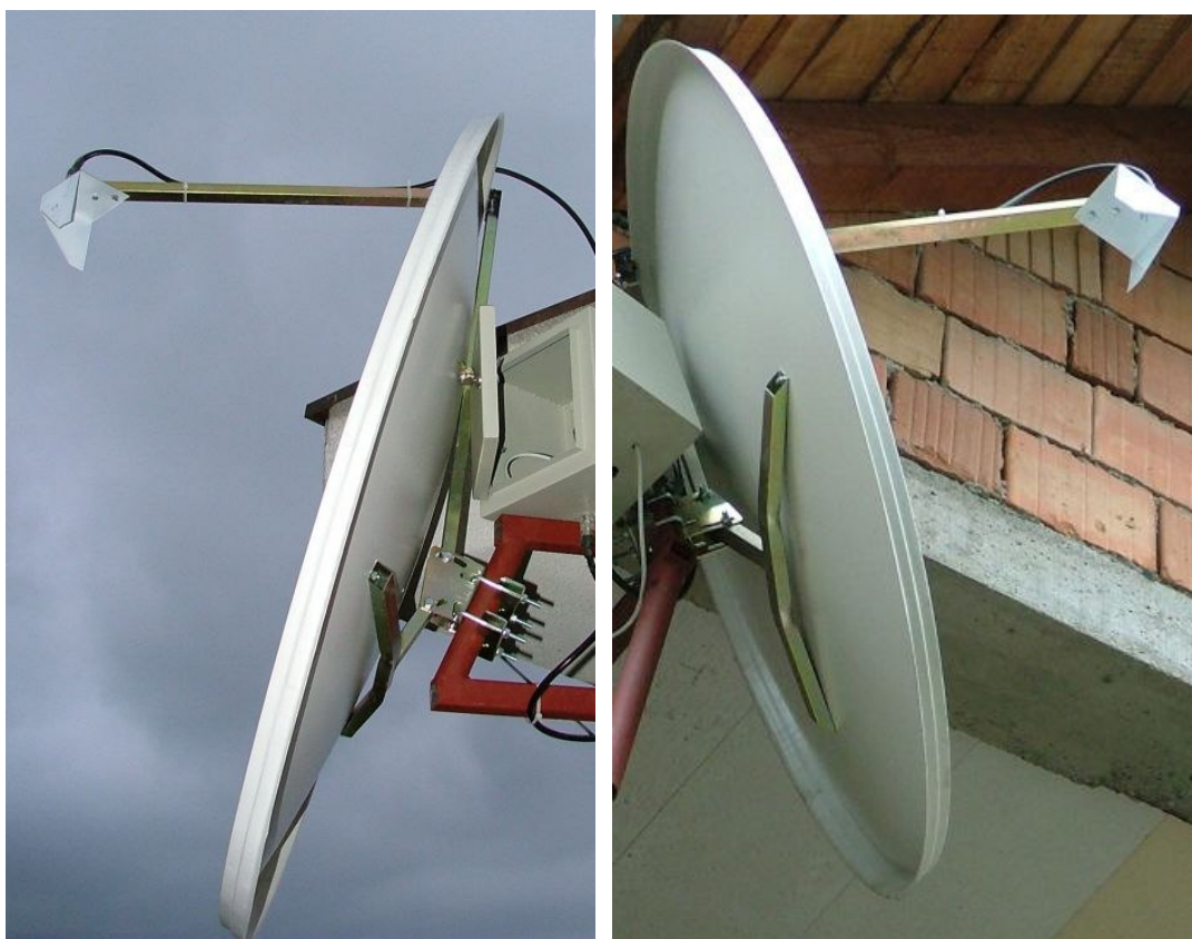
Sl. 19. Izgled montiranog zarubljenog 3D kornier fida na SAT TV ofset paraboli
