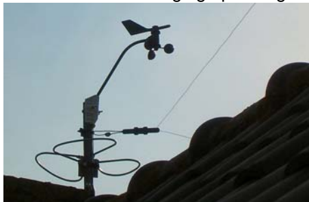
Hieronder de bevestiging op de eigen schoorsteen: daar waar de knik in de antenne zit
