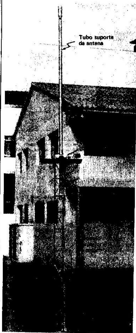
FOTO 1 — Módulo superior, vendo-se o rotor e o tubo suporte da antena.
