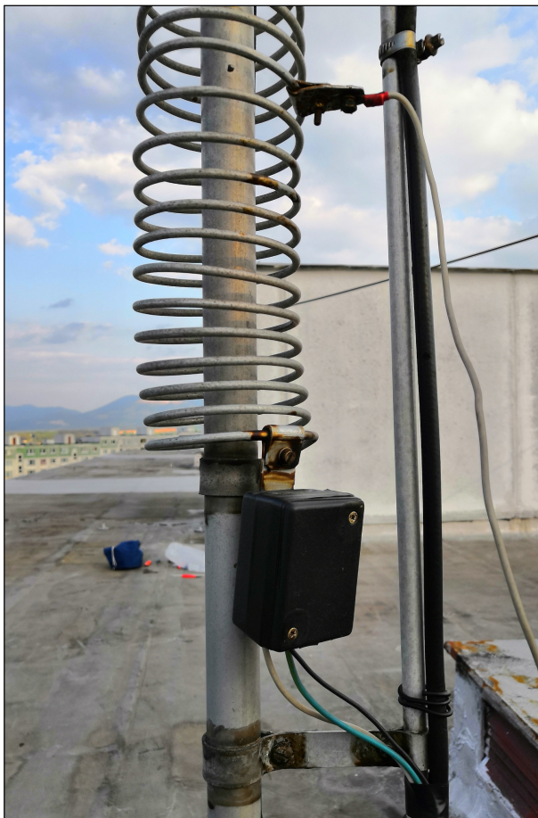
Obr. 4: Umiestenie krabičky s relé
