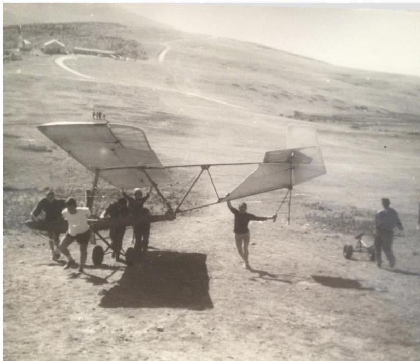
3-8 Subida de un Schulgleiter al punto de lanzamiento bajo el tornoN. Al fondo, junto al hangar nuevo, el primer barracón de madera. 1961.
