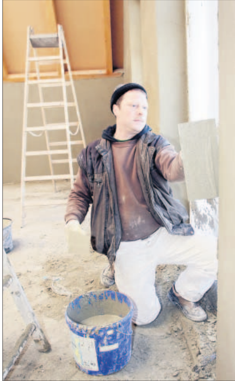
Außen ist bis auf den Putz und die Außenanlagen das Gerätehaus schon fast fertiggestellt. Innen haben die Handwerker aber noch kräftig zu werkeln: Derzeit bringen die Arbeiter von Stuck-Walter aus Radeberg – wie hier Udo Jaster im künftigen Schulungsraum – den Innenputz an. Komende Woche sollen die Heizungsbauer loslegen, bevor die Fußbodenfirma je nach Außentemperatur mit den Arbeiten beginnt. Foto: Michael Trapp
